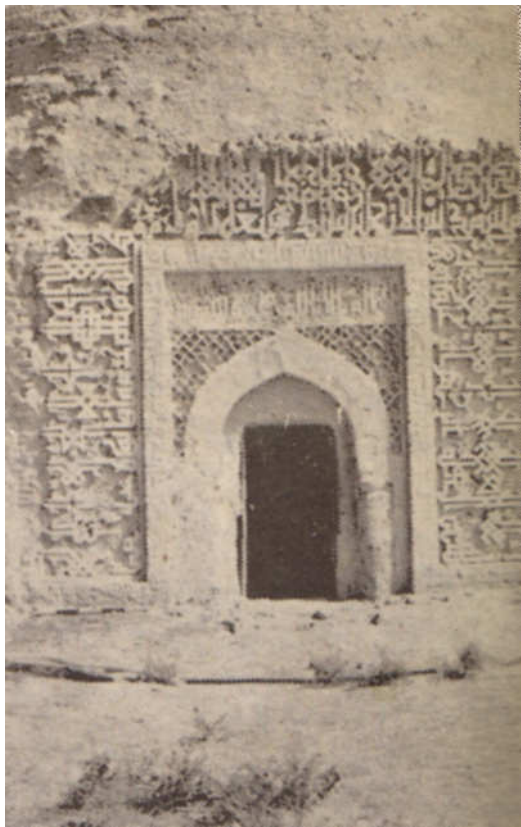
عکس نمره ۴ : مدخل مقبره باباحاتم قبل از ترمیم با کتیبه بزرگ خشتی اطراف آن و کتیبه گچی سردر که کلمه شریف طیبه میباشد.
