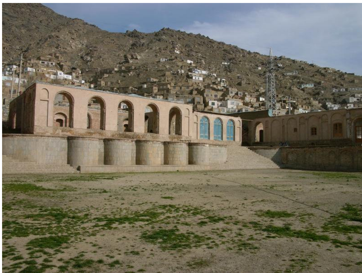
عکس شماره ۱۷ - داخل محوطه حرمسرای باغ بابر بعد از بازسازی قسمی توسط پروژ آغاخان. ۲۰۰۶ م. عمارت بازسازی شده بروی تهداب ها و صفحه های اصلی؛ آباد گردیده است.
